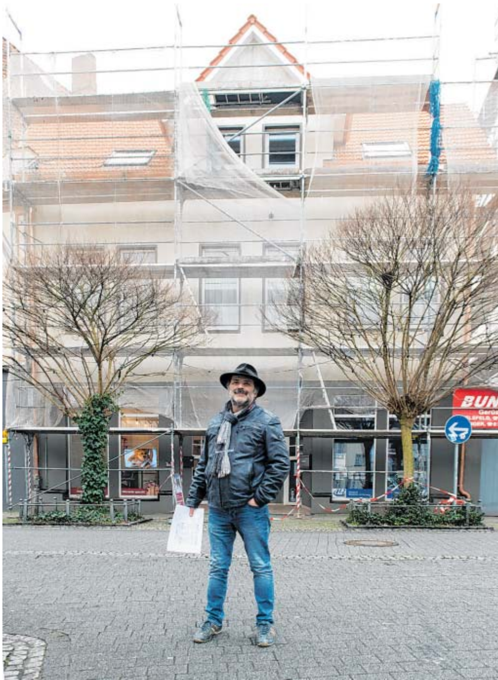
Eingerüstet: Mathias Polster vor dem Haus Radewiger Straße 31 dessen ursprünglich klassizistische Fassade neu gestaltet wird und einen Teil ihrer alten Gliederung zurückerhalten soll. FOTOS: RALF BITTNER
