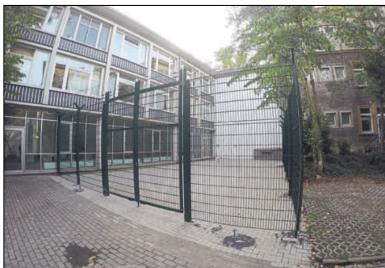
Die »gesicherte Gefangenenzuführung« befindet sich auf der Rückseite des Amtsgerichts. Foto: Moritz Winde
