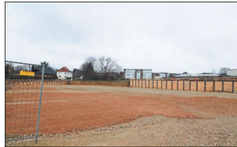
Der Baugrund ist planiert, die Spundwände sind gesetzt. In der nächsten Woche beginnen hier die Bauarbeiten. Fotos: Matthes
