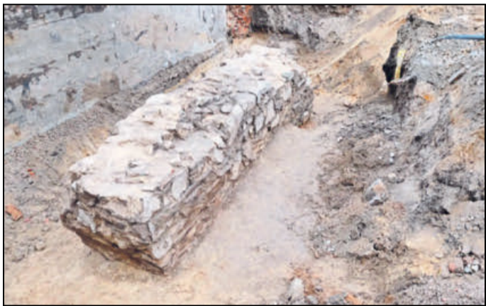
Diese alte Klostermauer wurde im März 2017 bei Arbeiten für das Altstadt-Centrum entdeckt. Foto: Moritz Winde
