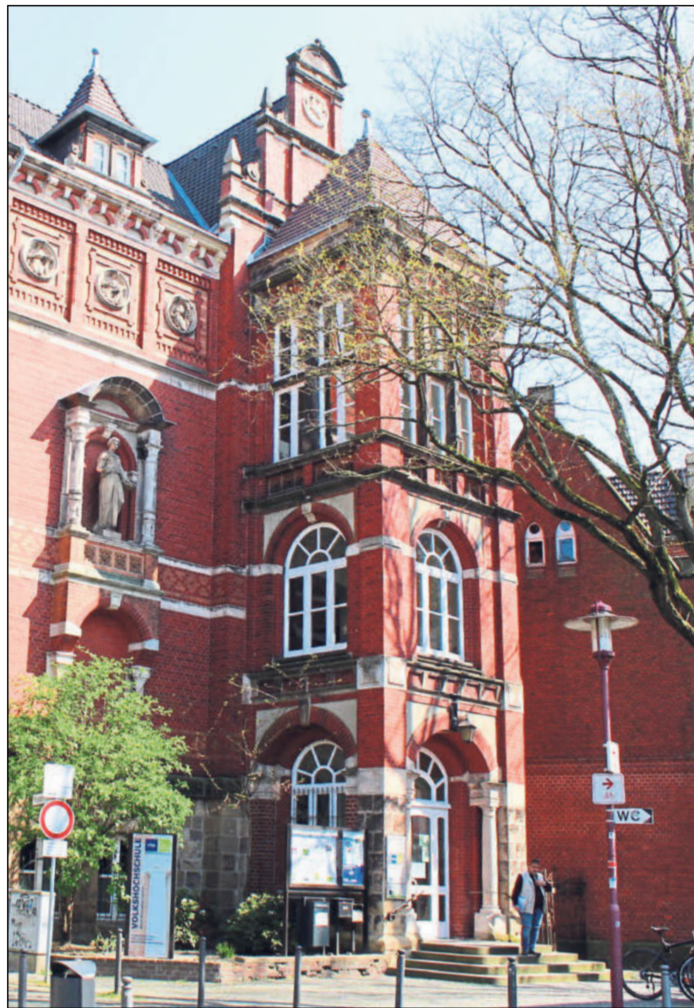
In dem Gebäude am Münsterkirchplatz in Herford hat die Volkshochschule des Kreises ihren Sitz. Hier sind die Verwaltung, aber auch zahlreiche Unterrichtsräume.
